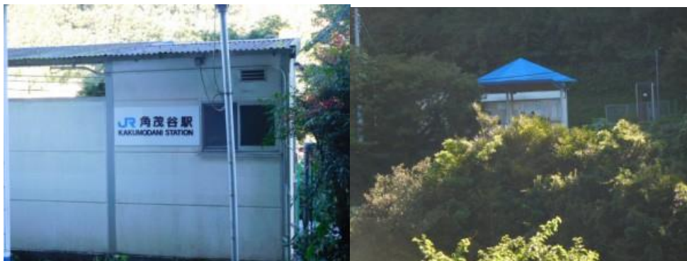
角茂谷駅 対岸からの角茂谷駅
